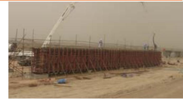
هنگامی که قالب بندی یک سازه بتُنی را نتوان با استفاده از انواع قالب‌های مدولار، کج‌ها و فیلرها انجام داد، برای آن سازه می‌بایست قالب خاص طراحی گردد. این قالب‌ها معمولاً برای سطوح دارای اشکال نامنظم، منحنی و دارای زوایای غیرقائم طراحی و ساخته می‌شوند.
